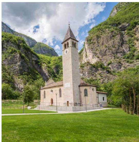
Chiesa di Zambana vecchia
