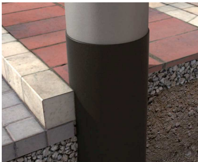
Fig. 19 – Particolare guaina termo-restringente alla base del palo.
