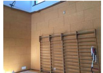
A entrare nel dettaglio è l'assessore ai lavori pubblici, Flavio Zandonai. «Abbiamo posato un pannello fonoassorbente in "eraclit". Il colore scelto è il giallo e il rivestimento arriva fino ai 5 metri di altezza. Sono state anche ritinteggiate le pareti perimetrali ed è stato rifatto l'impianto di illuminazione».
