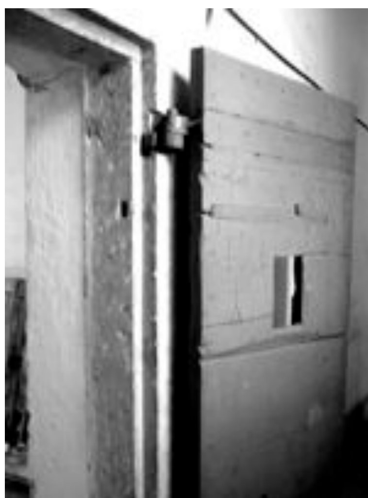
ALCUNI PARTICOLARI DEL PIANO TERRA
