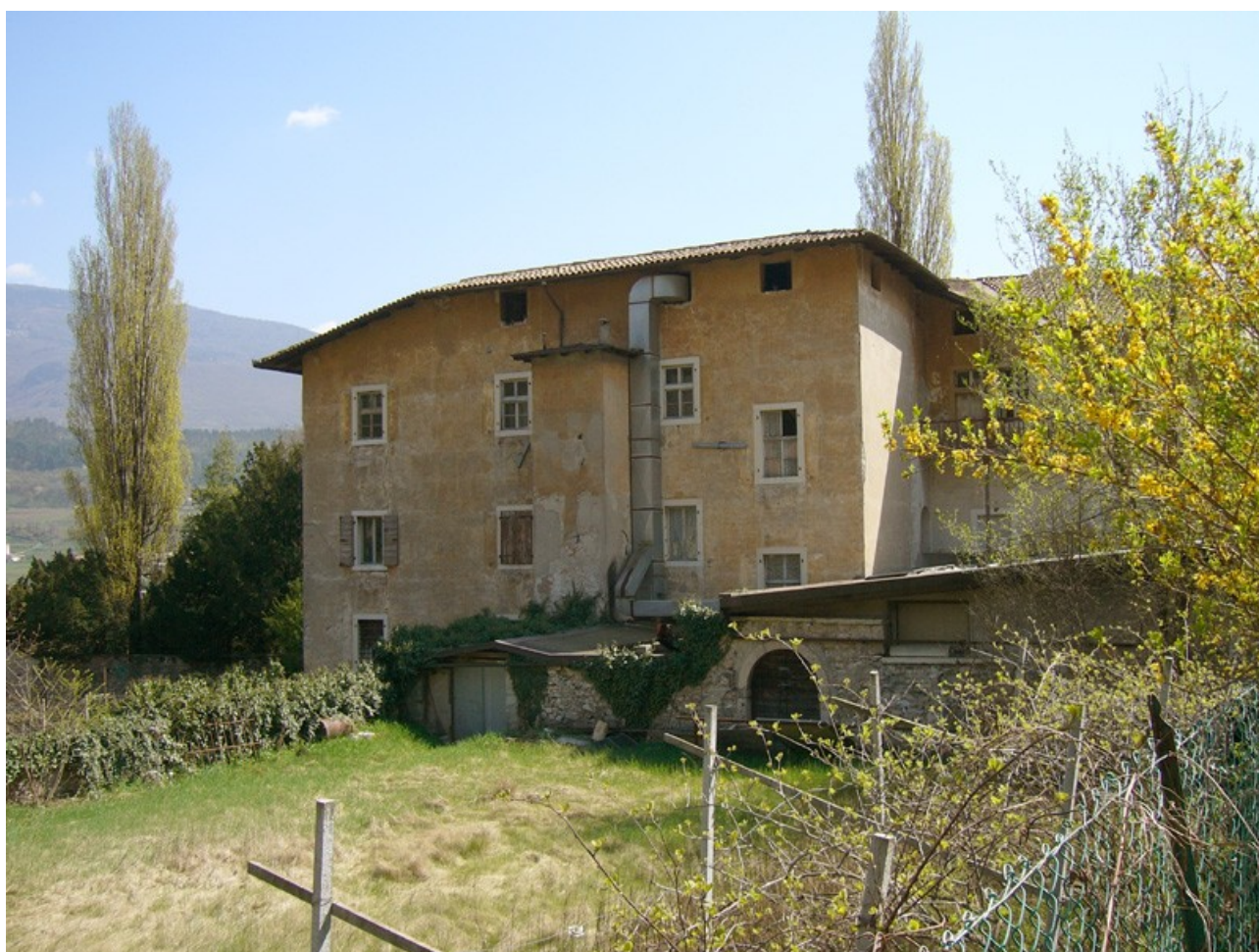
Porzione orientale della facciata nord con parte della p.f. 298/1
