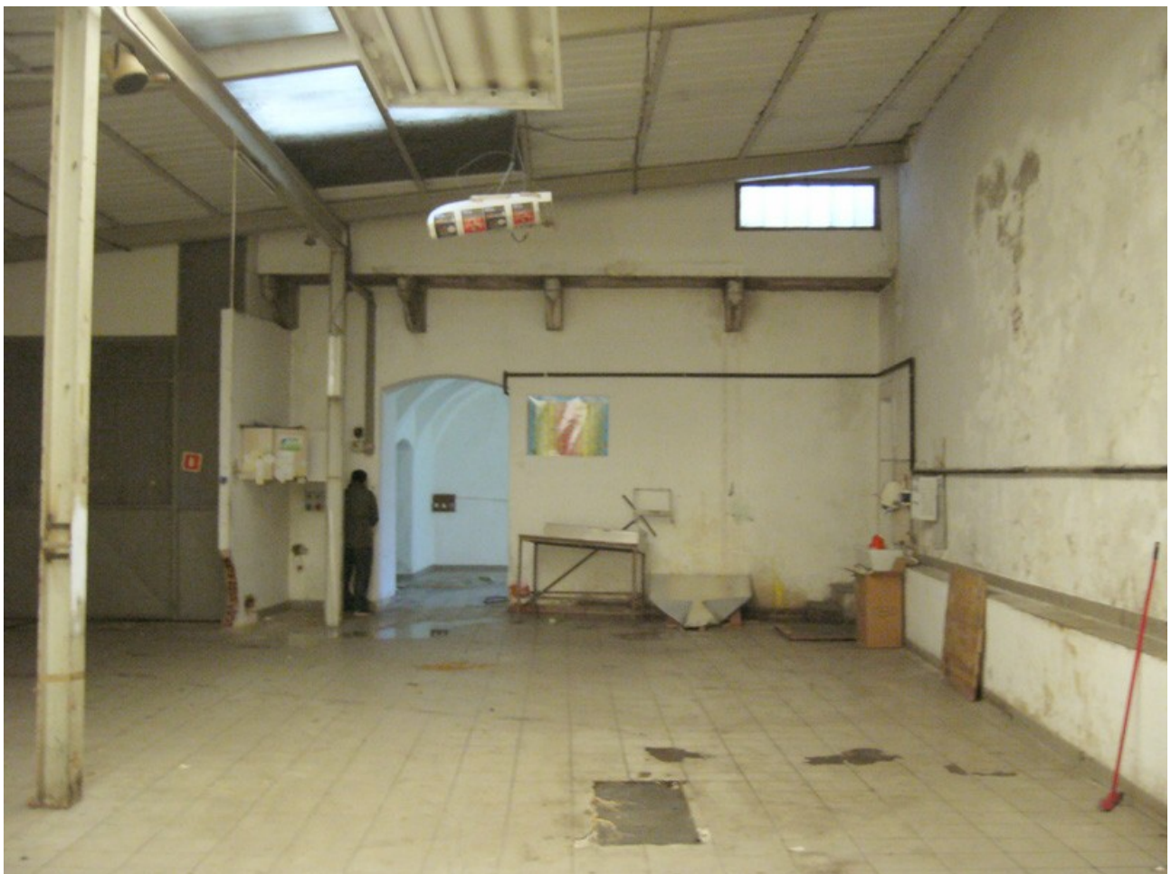
Piano terra – tettoia (superfetazione) verso il giardino a nord
