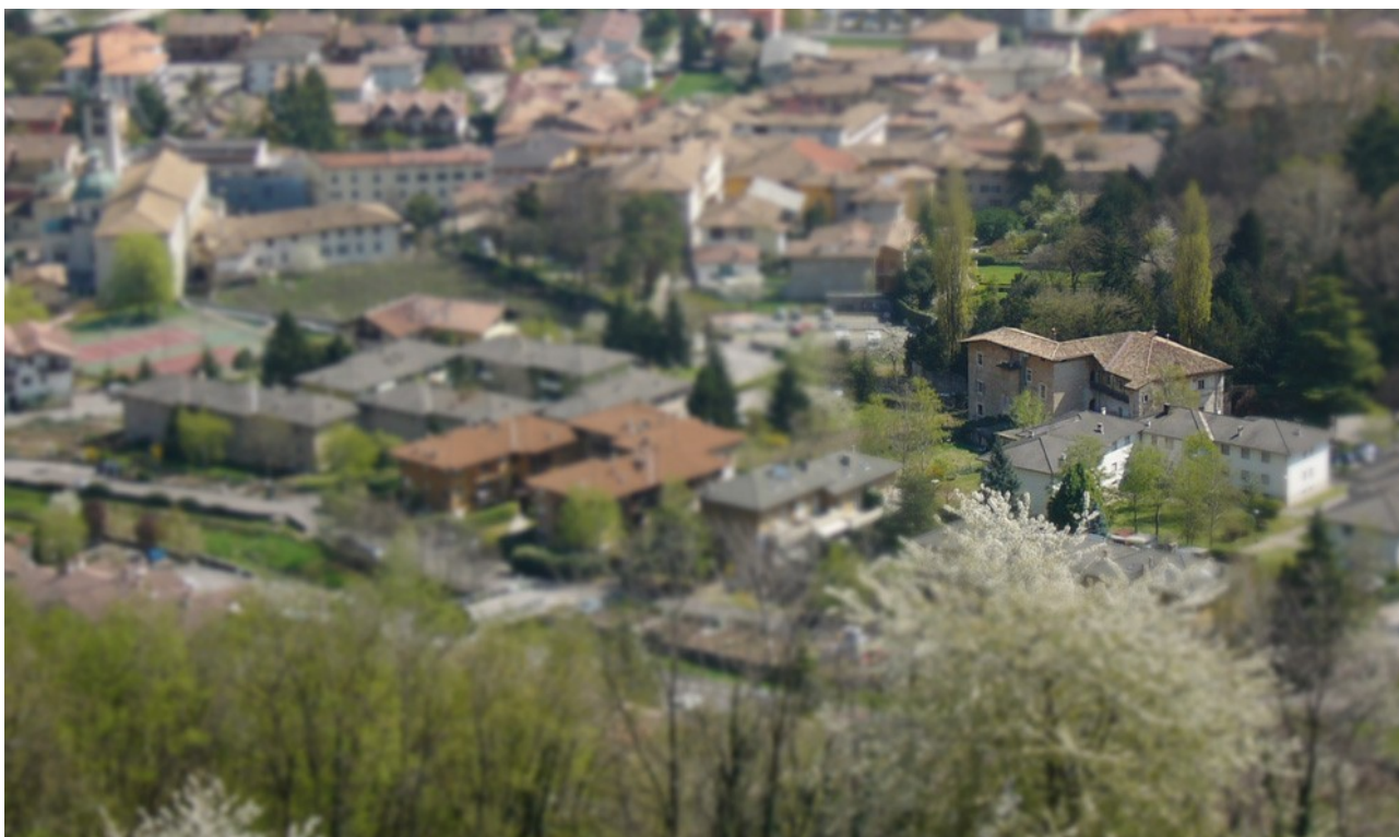
Vista dall'alto (con messa a fuoco sul solo ex Monte di Pietà)
